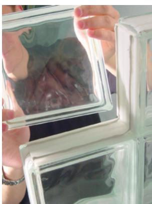
10. Швы между стеклянными блоками могут заполняться смесями для швов керамической плитки (например, Ceresit CE-40). Следите за инструкциями изготовителя смеси для заполнения швов.
